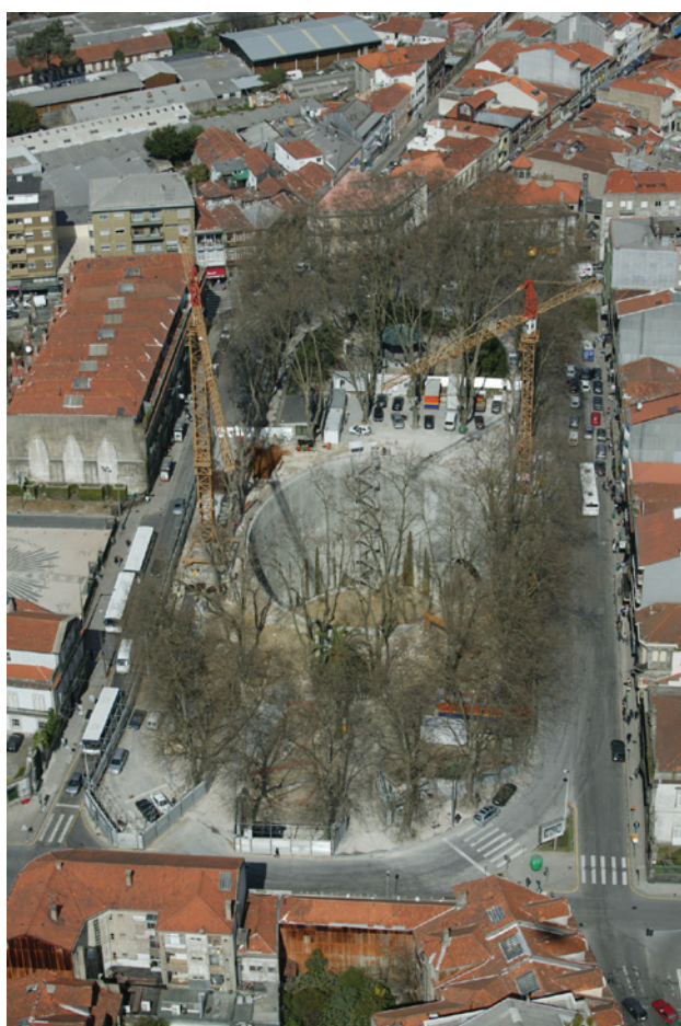
Figura 2 – Poço para construção da Estação do Marquês. Foto Engenho/Metro do Porto.
