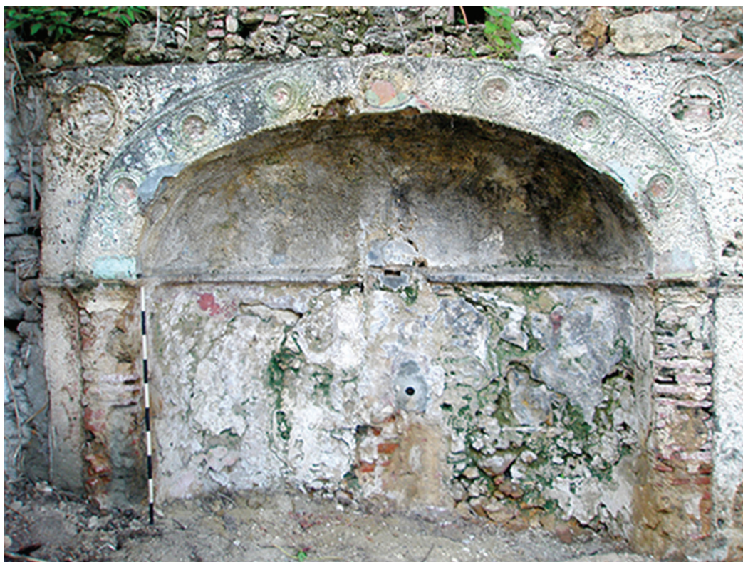
Figura 3 – Estado atual de conservação da fonte.
