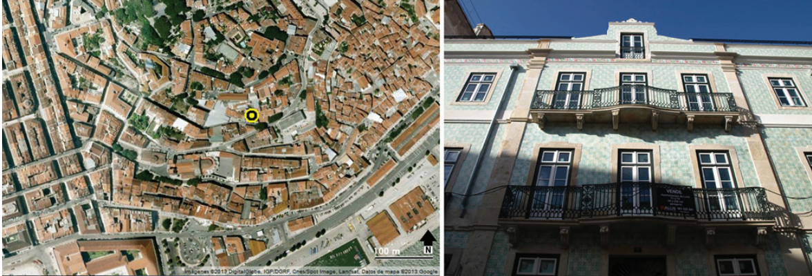
Figura 1 – Localização do edifício (fonte Google Earth 2013). Fachada do edifício.
