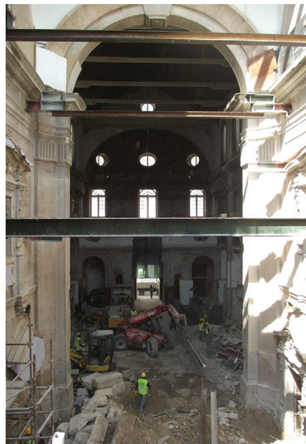
Figura 2 – Vista dos trabalhos na Igreja de São Julião. © Artur Rocha/Arqueohoje.
