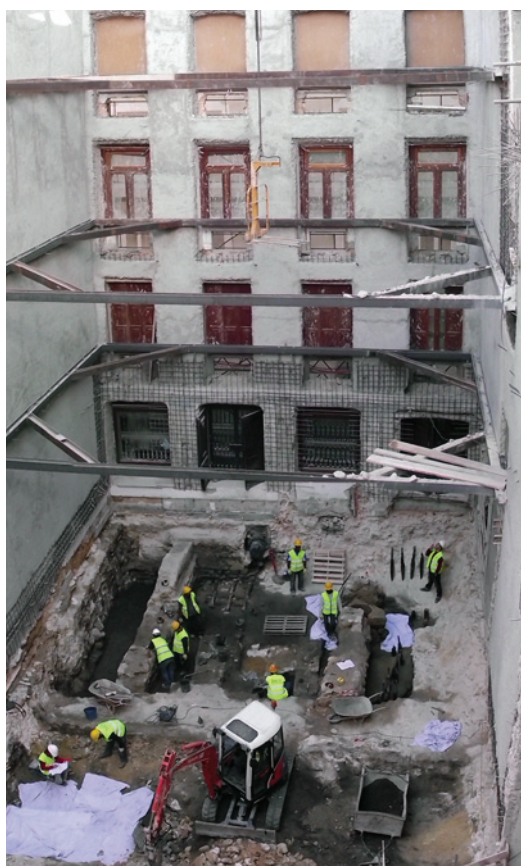
Figura 1 – Vista dos trabalhos nos edifícios correntes após demolição dos pisos superiores. © Artur Rocha/Arqueohoje.
