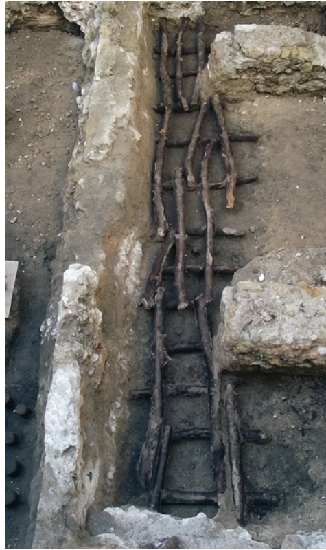
Figura 4 – Vista de troço de estacaria pombalina e da parte remanescente dos alicerces da Rua da Judiaria Nova. © Artur Rocha/Arqueohoje.
