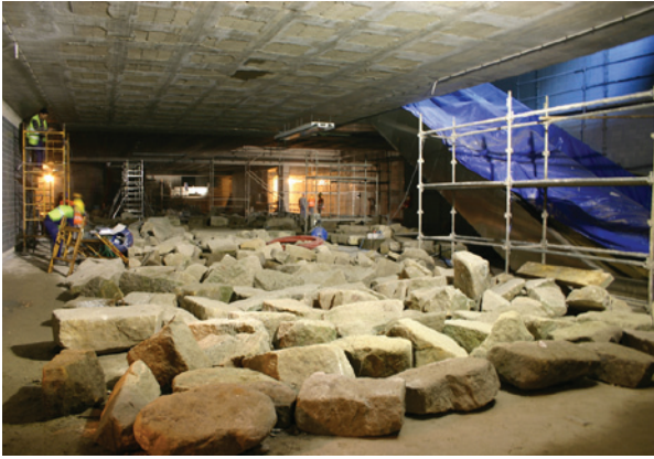
Figura 8 – Imagem do Mezanino Intermédio da estação Campo 24 de Agosto, com a distribuição das pedras para posterior remontagem. Arquivo Metro do Porto, por Foto Engenho.
