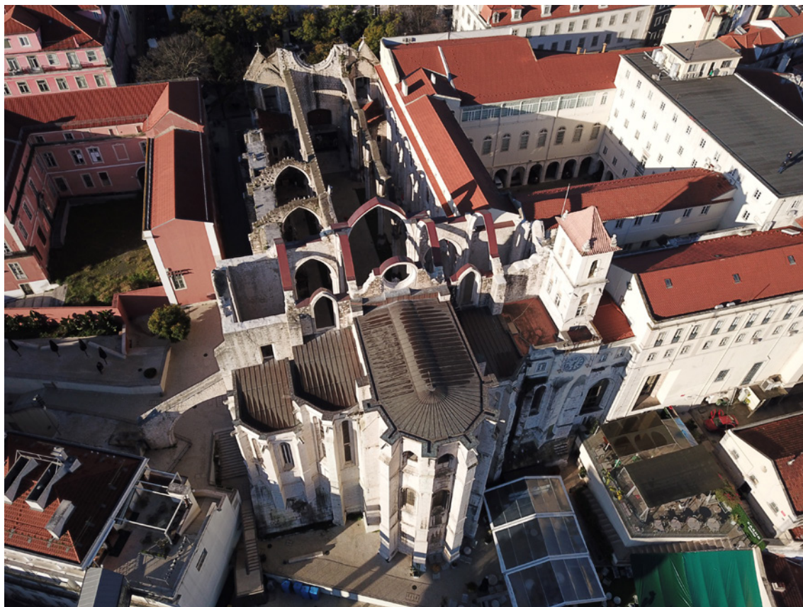
Figura 2 – Aspecto final da obra de conservação e restauro da zona do transepto da antiga Igreja do Carmo.
