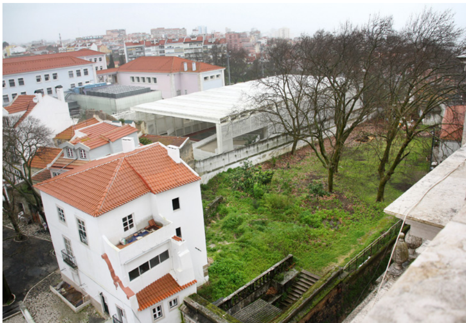
Figura 2 – Vista geral da área de intervenção – sentido nordeste (foto do autor).
