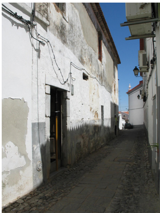
Figura 7 – Edifícios n.ºs 29-33 da Rua da Barbacã (© Ana Sofia Antunes).
