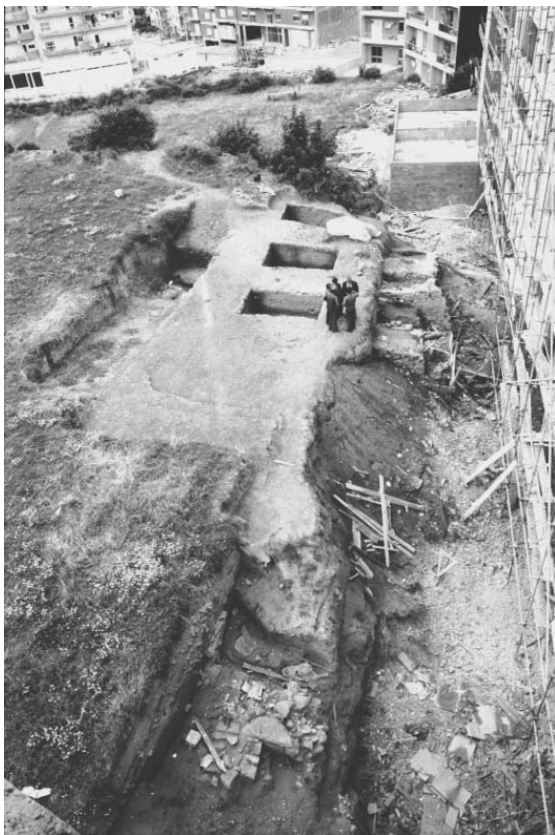
Figura 1 – O local exacto onde a urbanização do Alto da Cidade foi bloqueada por decisão do I Governo Constitucional (ao tempo não se sabia, mas a compra dos terrenos do Alto da Cidade permitiu salvar as estruturas do Teatro romano e dos banhos anexos, exaustivamente estudadas por Manuela Martins na década de 90 e já neste século).
