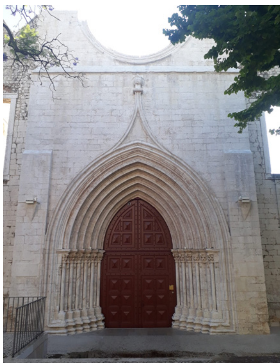
Figura 6 – Aspecto final do Portal Oeste do Carmo após os trabalhos de conservação e restauro.
