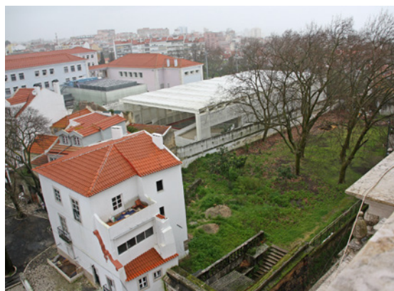
Figura 7 – Vista actual e parcial da cerca a Norte do mosteiro. Fotografia do autor.
