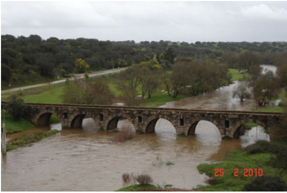
Figura 5 – Ponte Romana de Vila Formosa na EN 369.
