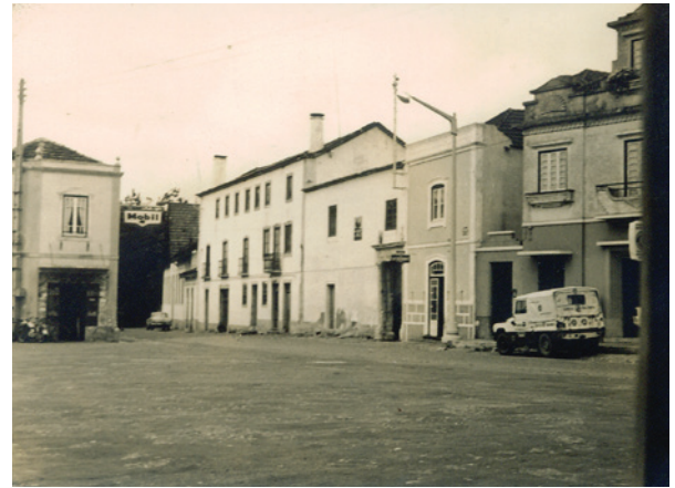
Figura 4 – Ao fundo e à direita, o edifício de três pisos onde existiu a sede do primeiro núcleo museológico do Bombarral (imagem datada de 31-05-1967). Arquivo do Museu Municipal do Bombarral.
