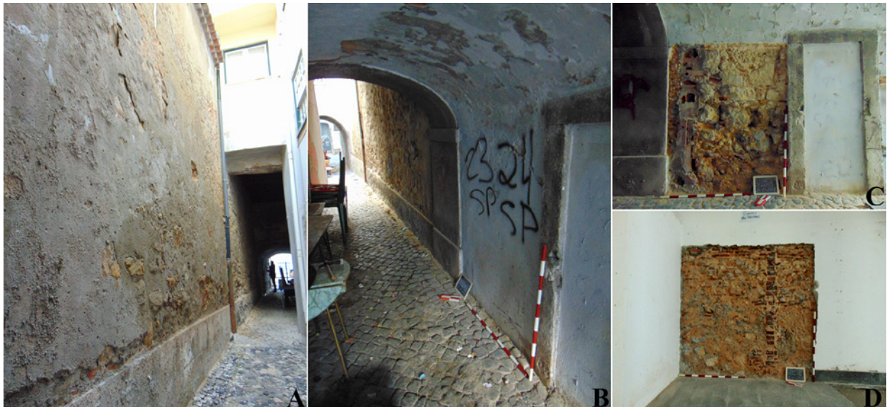
Figura 4 - Vista em profundidade sobre os tardozes dos prédios da rua de Terreiro do Trigo desde o Beco dos Curtumes, a partir de O (A) e E (B). Sondagem parietal 1 (C) e sondagem parietal 2 (D).
