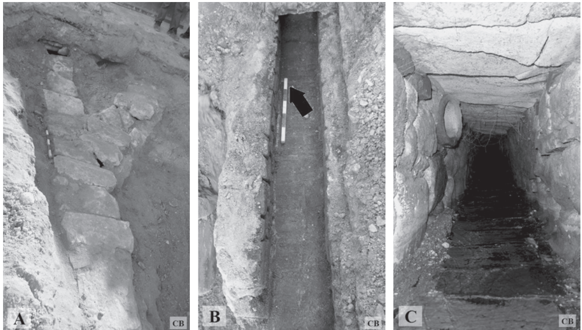
Figura 18 – A – Cruzamento da condutas de saneamento da Rua Miguel Bombarda com a da Rua Braamcamp Freire no Largo Pedro António Monteiro; B – Vista do interior da conduta da Rua Braamcamp Freire após remoção da cobertura vendo-se as lajes de cerâmica do pavimento; C – Perspectiva do interior da conduta da Rua Braamcamp Freire. Fotos: C. Boavida.
