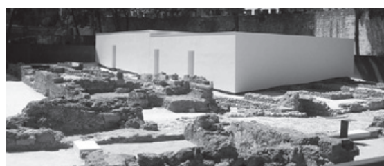
Figura 13 (em cima) – Aspeto da construção da estrutura de proteção do núcleo islâmico.
